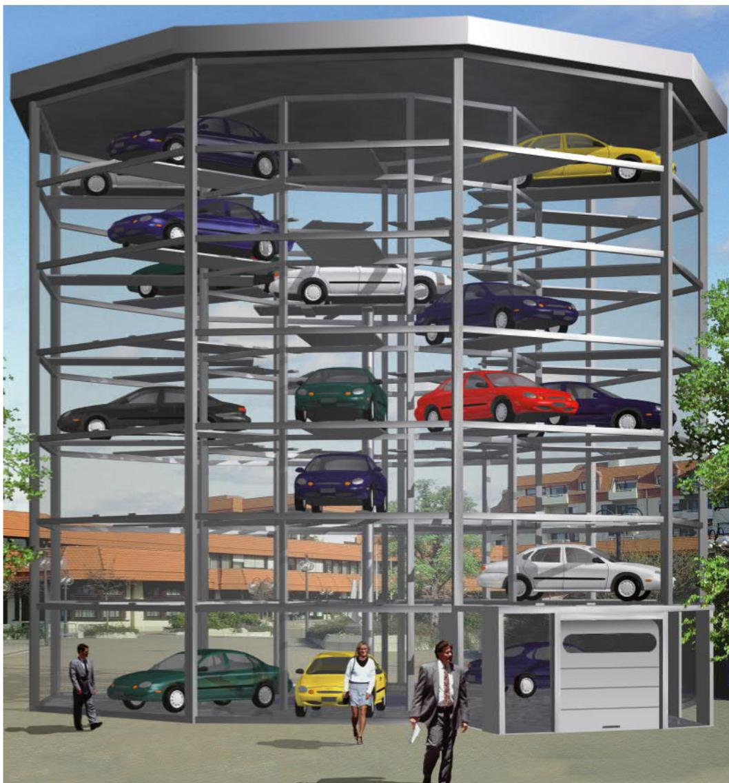
Parksafe 585 è un sistema di parcheggio per automobili gestito in modo automatico e dotato di compartimenti intorno al trasportatore verticale centrale.
